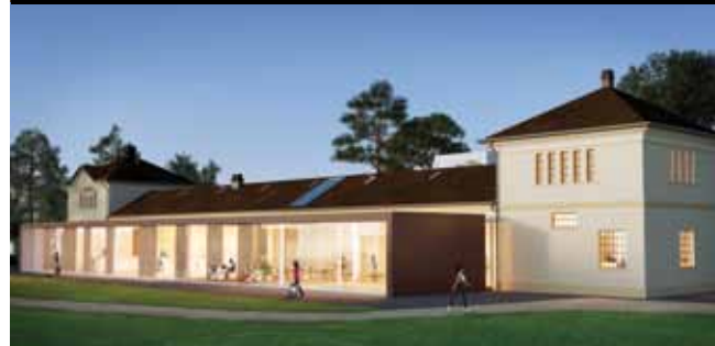
Planungsidee und Ausführung: NaiApollo und Real Grundbau GmbH
